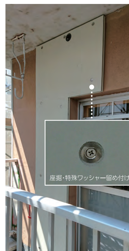
GSF外断熱パネル 施工中
