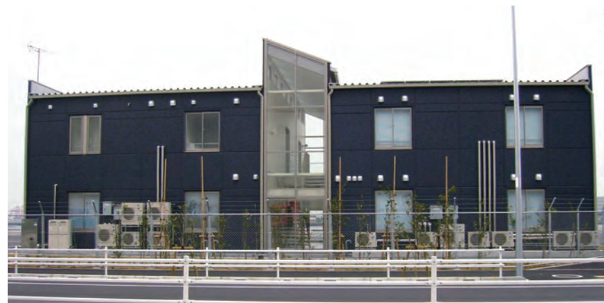
中央防波堤・ふ頭荷役連絡所新築工事
