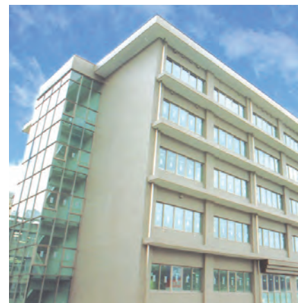
鉄筋コンクリート造 GS-Tパネルによるタイル仕上げ
