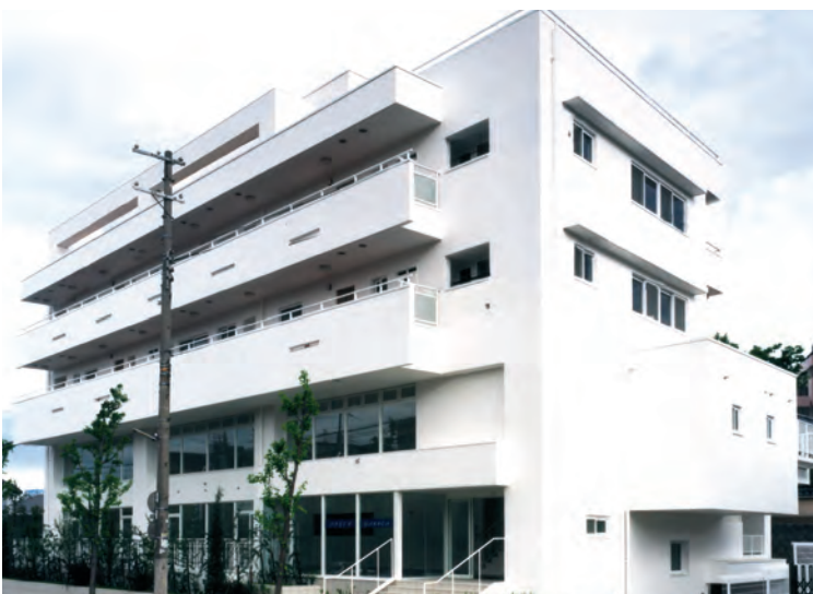
鉄筋コンクリート造 GSパネル一部後貼り塗装仕上げ
