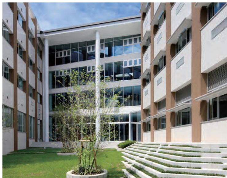
庇・ドット柄外断熱パネル(特注品) 京都府内私立中学校高等学校新築工事
