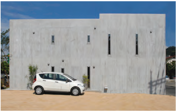
鉄筋コンクリート造 GSパネルによる打ち込み工法
