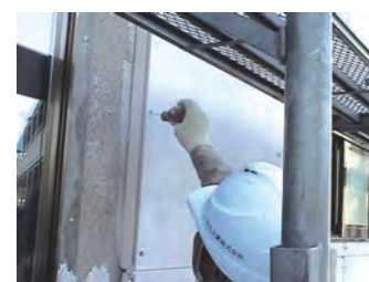
座掘位置に躯体まで孔明け後、清掃
