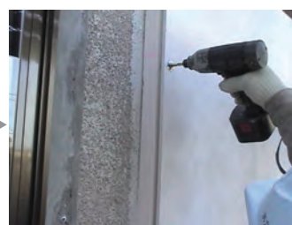
ボルトの締め込み
