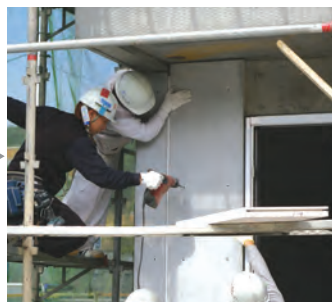
パネル取り付け
