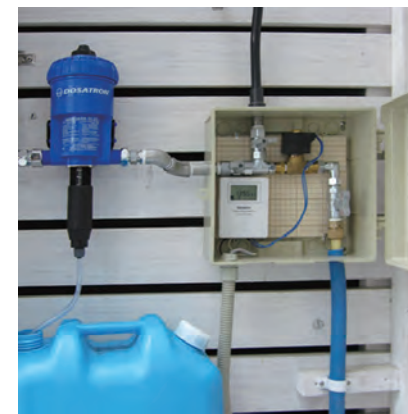
灌水装置のタイマーと自動液肥散布装置
