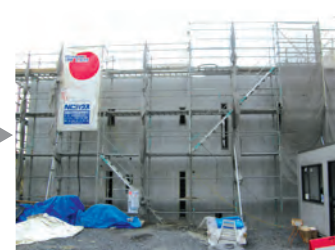
GS外断熱パネル工事終了
