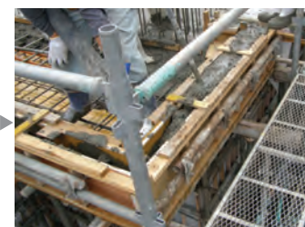
コンクリート打設
