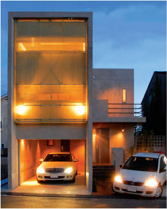
鉄筋コンクリート造 GSパネルによる打ち込み工法
