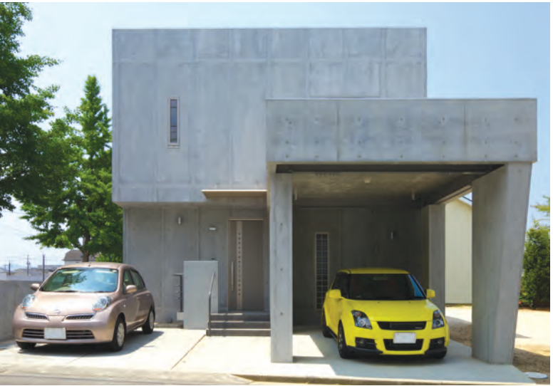
木造 GSWパネルによる素地仕上げ
