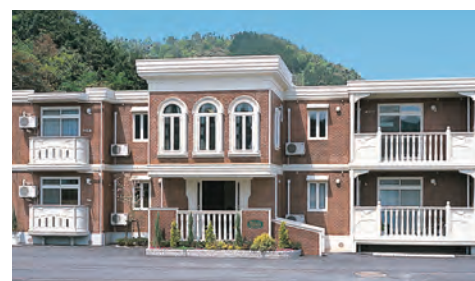
NCハウス集合住宅意匠・柱・手摺・窓装飾・パラペット
