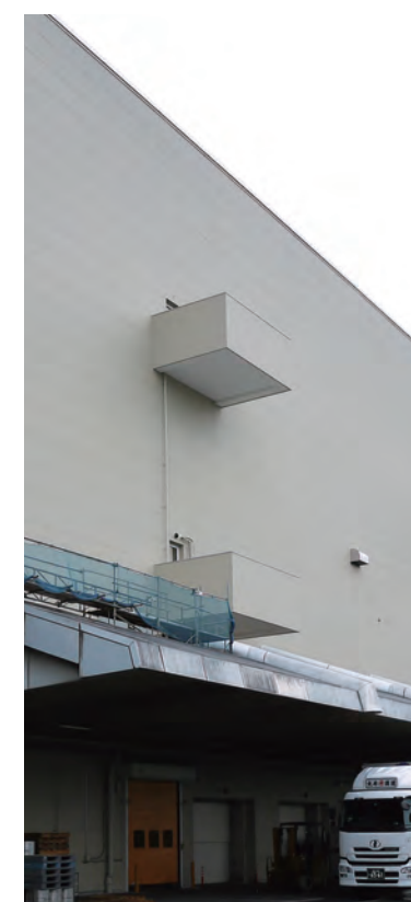
GSF外断熱パネル 改修
