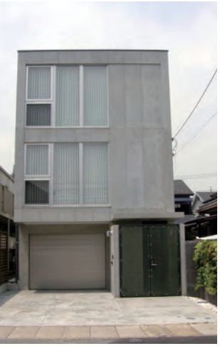
鉄筋コンクリート造 GSパネルによる打ち込み工法
