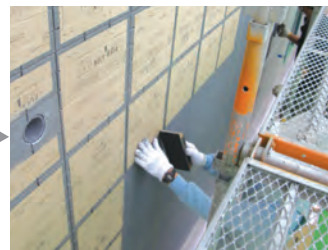
接着剤塗布、タイル貼り
