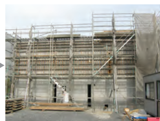
コンクリート養生後脱型
