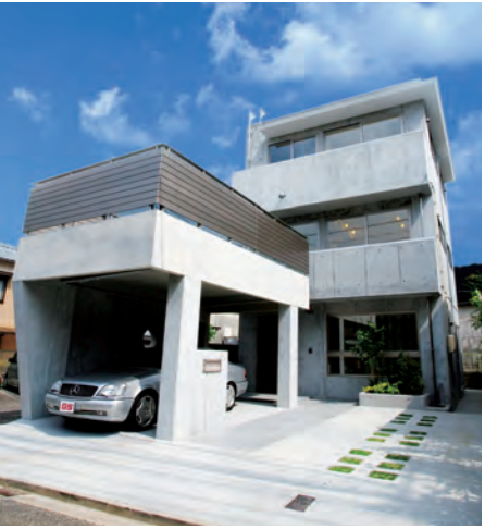
1F鉄筋コンクリート造 GSパネルによる後貼り工法 2F・3F鉄骨造 GSSパネルによる素地仕上げ
