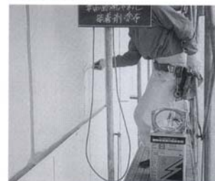
3. アンカー打ち込み
