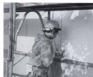
3. アンカー打ち込み
